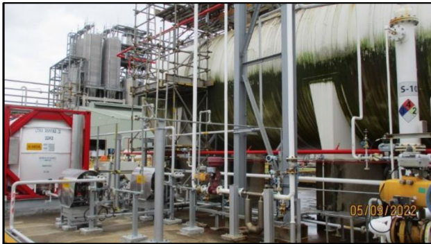
ภาพที่ 2.2-1 Water Scrubber บริเวณถังเก็บ Propylene Oxide
