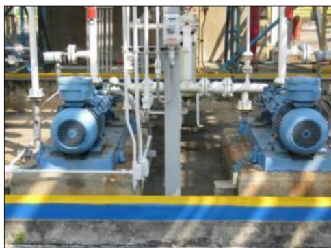
ภาพที่ 2.2-10 Pump ที่ใช้ขนถ่ายสาร Propylene Oxide
