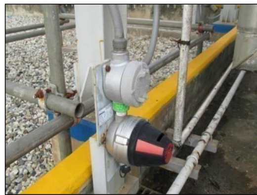
ภาพที่ 2.2-8 อุปกรณ์ตรวจสอบความปลอดภัย เช่น Gas Detector, Smoke Detector
