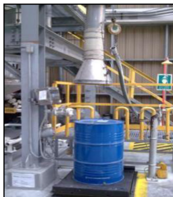
พัฒลมดูดอากาศบริเวณสูบลายสารเคมีจากถัง
