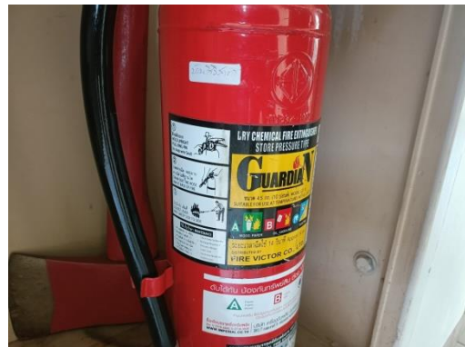
รูปที่ 2-16 ถังดับเพลิงเคมีพร้อมป้ายวิธีการใช้
