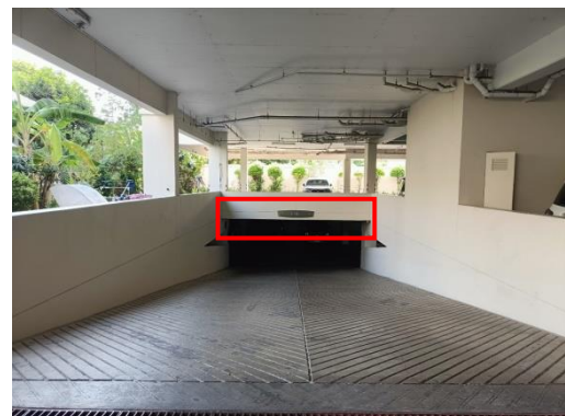
รูปที่ 2-49 ป้อนน้ำดับเพลิงใต้ดิน
