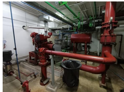
รูปที่ 2-47 ป้อนน้ำใช้/ป้อนน้ำดับเพลิง ชั้นคาตฟ้า
