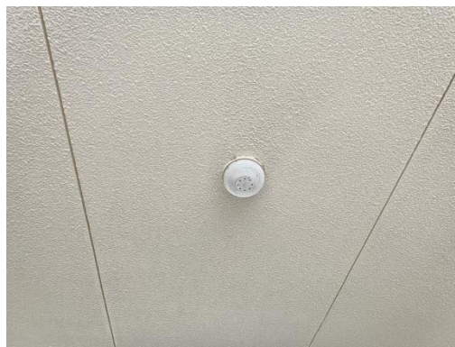
รูปที่ 2-24 เครื่องตรวจจับควัน/ความร้อน
