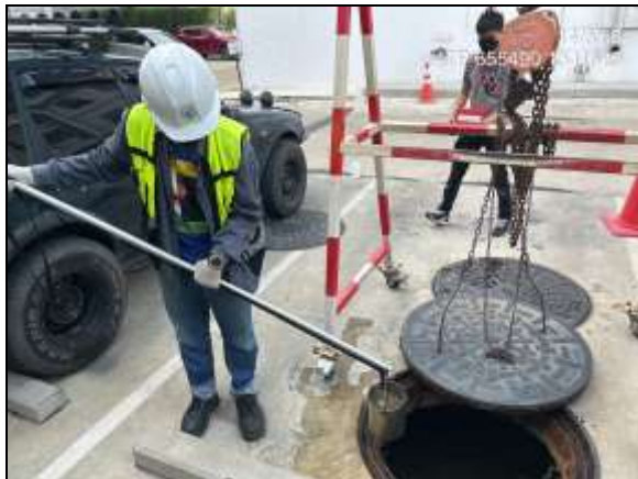
ส่วนแยกกากของระบบบำบัดน้ำเสีย อาคาร B
