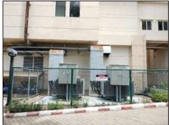
ภาพถ่าย 3-11 หม้อแปลงชนิด Oil Type
