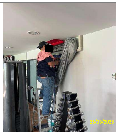
รูปที่ 38 ทำความสะอาดเครื่องปรับอากาศของโครงการ
