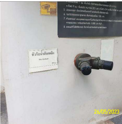
รูปที่ 36 ติดตั้งหัวรับน้ำดับเพลิงด้านหน้าโครงการ
