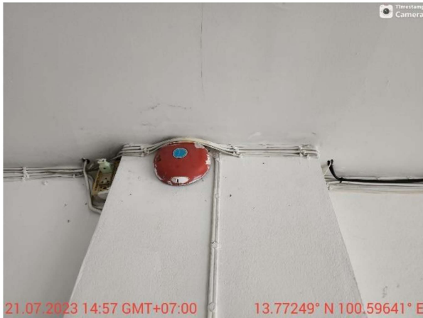
ภาพที่ 2-7 การเดินสายไฟภายในโครงการเป็นระเบียบเรียบร้อยและตรงตามมาตรฐาน
