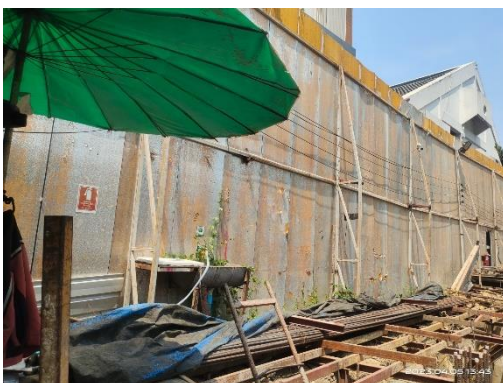
รูปที่ 25 การปิดคลุมวัสดุก่อสร้าง/เศษวัสดุที่มีฝุ่นด้วยผ้าใบ
