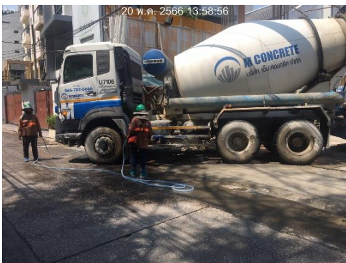
รูปที่ 32 ฉีดล้างล้อรถก่อนออกโครงการ
