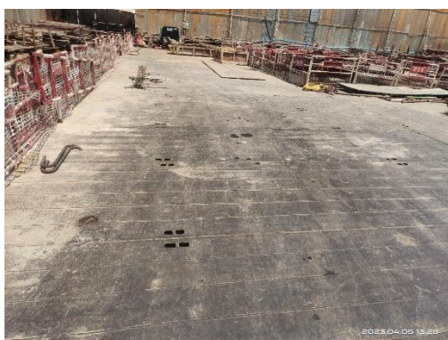
รูปที่ 21 การปูแผ่นเหล็กบริเวณทางเดินรถ
