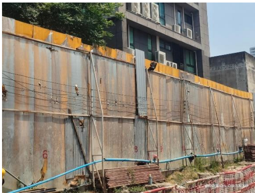
รูปที่ 16 รั้วชั่วคราวแบบ Metal sheet
