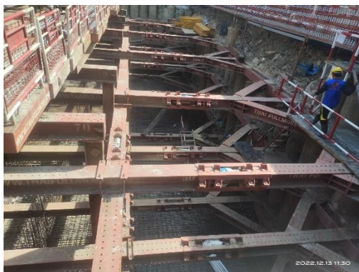
รูปที่ 20 Sheet Pile และระบบค้ำยัน
