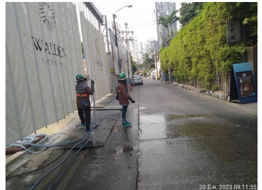
รูปที่ 26 สเปรย์น้ำลดการฟุ้งกระจายของฝุ่นละอองบริเวณแนวรั้ว
