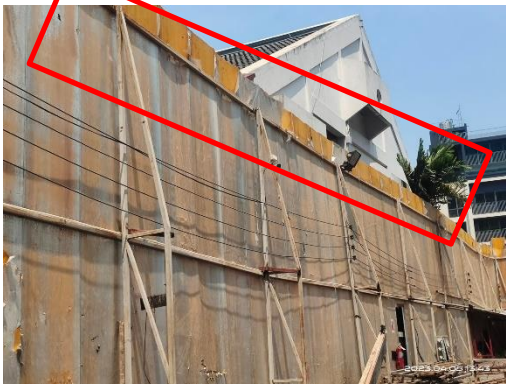
รูปที่ 26 สเปรย์น้ำลดการฟุ้งกระจายของฝุ่นละอองบริเวณแนวรั้ว
