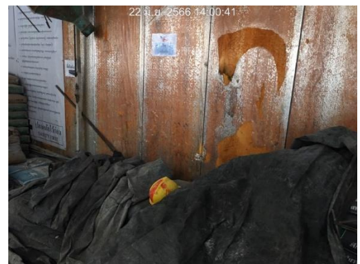
รูปที่ 25 การปิดคลุมวัสดุก่อสร้าง/เศษวัสดุที่มีฝุ่นด้วยผ้าใบ
