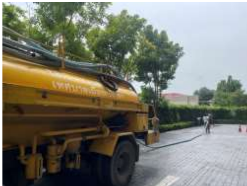
รูปที่ 8 สู้บกาตะกอนออกจากระบบบำบัดน้ำเสีย
