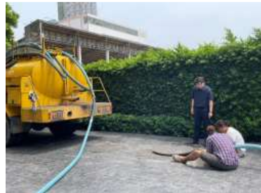
รูปที่ 8 สู้บกาตะกอนออกจากระบบบำบัดน้ำเสีย
