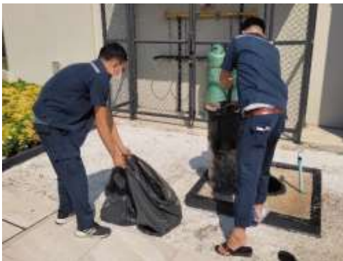
รูปที่ 56 เจ้าหน้าที่ทำความสะอาดถังดักไขมัน
