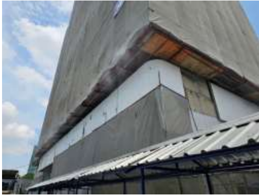
รูปที่ 56 ตะแกรงป้องกันวัสดุตกหล่นโดยรอบอาคาร
