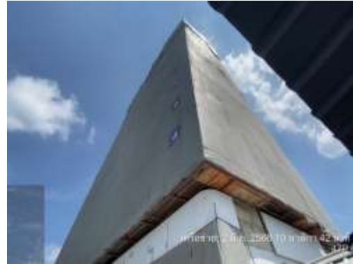
รูปที่ 22 ติดตั้งผ้าใบการก่อสร้าง (Mesh Sheet ชนิดกันไฟลุกลาม) คลุมอาคาร
