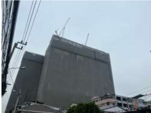
รูปที่ 22 ติดตั้งผ้าใบการก่อสร้าง (Mesh Sheet ชนิดกันไฟลุกลาม) คลุมอาคาร
