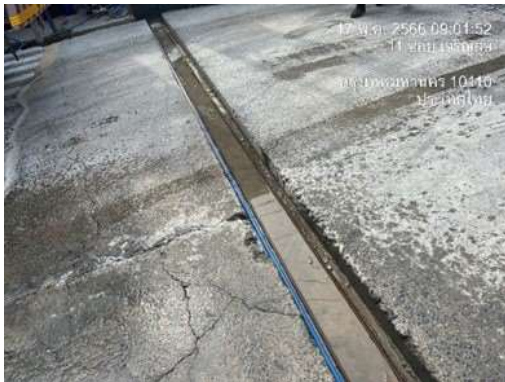
รูปที่ 53 รางระบายน้ำและปัดกักตะกอน
