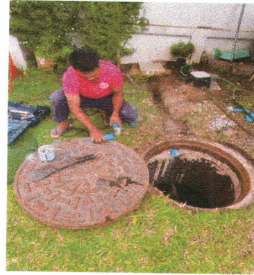
ภาพ 2-12 เจ้าหน้าที่กำลังติดตั้งอุปกรณ์เพื่อนำน้ำทิ้งมารดน้ำต้นไม้ และบริเวณที่อยู่ระหว่างการติดตั้งป้าย “ใช้น้ำทิ้งรดน้ำต้นไม้”
