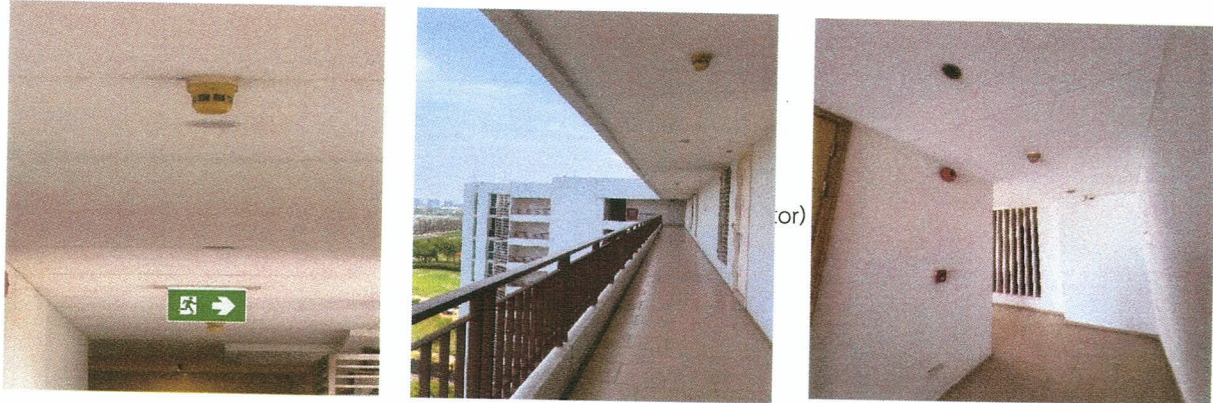
ภาพ 2-28 เครื่องตรวจจับความร้อน (Heat Detector)
