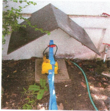
ภาพ 2-12 เจ้าหน้าที่กำลังติดตั้งอุปกรณ์เพื่อนำน้ำทิ้งมารดน้ำต้นไม้ และบริเวณที่อยู่ระหว่างการติดตั้งป้าย “ใช้น้ำทิ้งรดน้ำต้นไม้”
