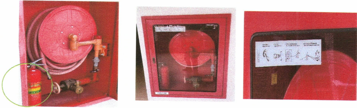
ภาพ 2-21 ตู้เก็บสายฉีดน้ำดับเพลิงพร้อมอุปกรณ์ (FHC) และถังเคมี
