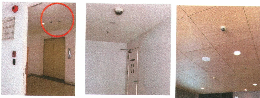
ภาพ 2-23 มีการติดตั้งระบบดับเพลิงอัตโนมัติ (Sprinkle System)
