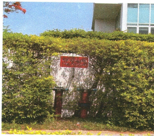
ภาพ 2-22 หัวรับน้ำดับเพลิงภายนอกอาคาร ติดตั้งบริเวณทิศตะวันออกใกล้กับทางเข้า-ออกโครงการ
