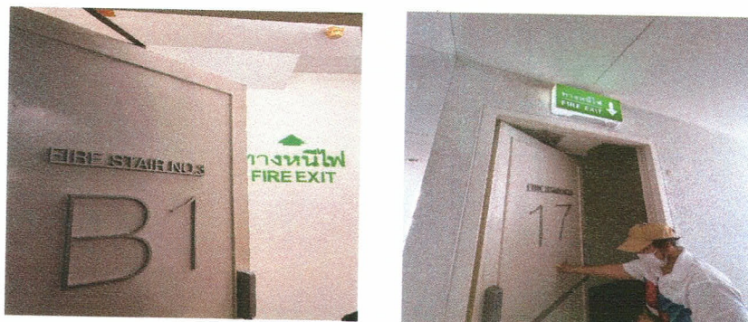
ภาพ 2-29 โครงการ มีประตูกันไฟกั้นระหว่างทางเดินภายในอาคารกับบันไดหนีไฟในแต่ละชั้น
