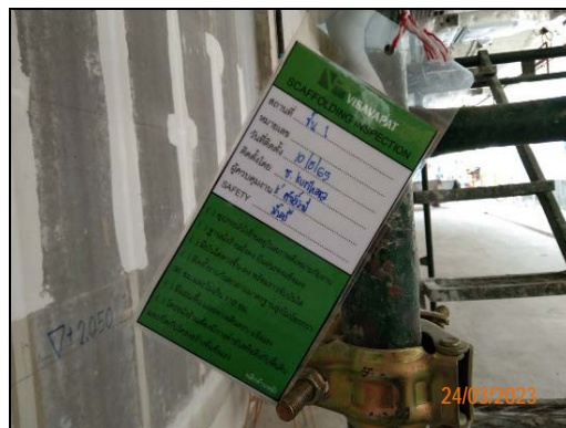
ภาพที่ 2.2-23 ป้ายการตรวจสอบนั่งร้าน
