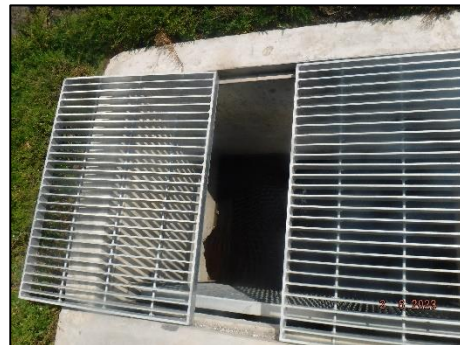
ตะแกรงดักมูลฝอยที่บ่อพักน้ำสุดท้ายก่อนระบายออก
