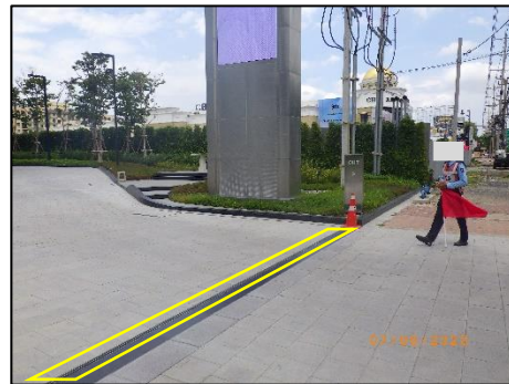
รูปที่ 2-19 ระบบท่อระบายน้ำ รองรับน้ำหลาก
