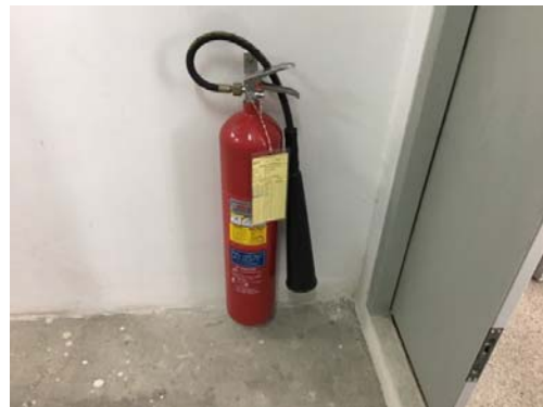
รูปที่ 28 อุปกรณ์ดับเพลิง แบบมือถือ
