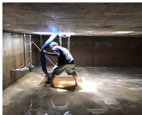
รูปที่ 58 ทำความสะอาดถังพักน้ำ
