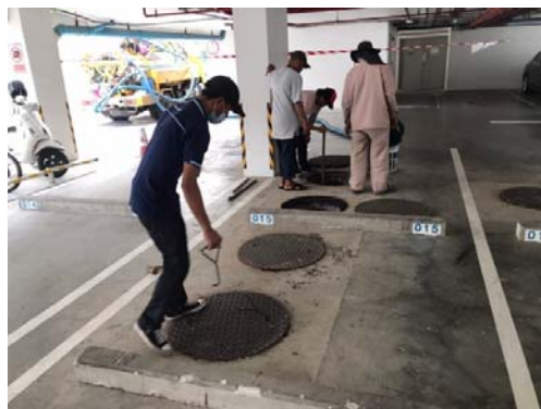
รูปที่ 56 การสูบล้างก่อนจากบ่อเกรอะ
