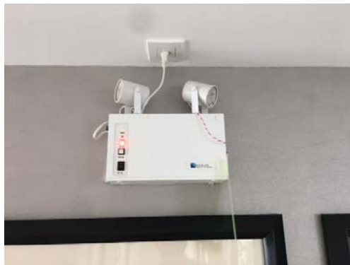
รูปที่ 27 ระบบไฟฉุกเฉิน
