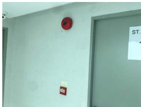
รูปที่ 44 กริ่งสัญญาณเตือนภัย
