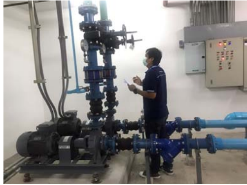
รูปที่ 80 เครื่องสูบน้ำจากชั้นใต้ดินไปยังชั้นตาดฟ้า
