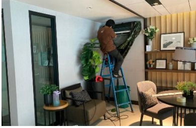
ภาพที่ 2-52 การทำความสะอาดเครื่องปรับอากาศ
