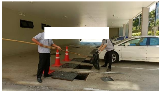
ภาพที่ 2-13 การตัดไขมันจากระบบบำบัดน้ำเสีย
