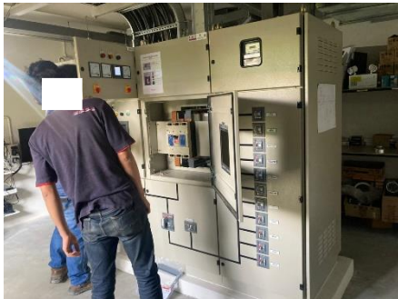
ภาพที่ 2-45 การตรวจสอบสายไฟหลักและอุปกรณ์ไฟฟ้า
