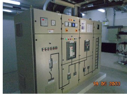
ภาพที่ 2-53 อุปกรณ์ตัดกระแสไฟฟ้าแบบอัตโนมัติ
