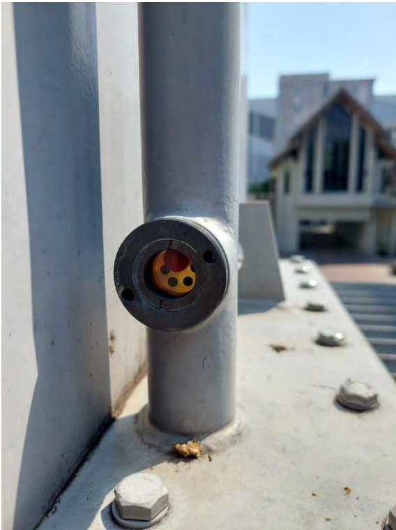
ระดับน้ำมันหม้อแปลงไฟฟ้า
