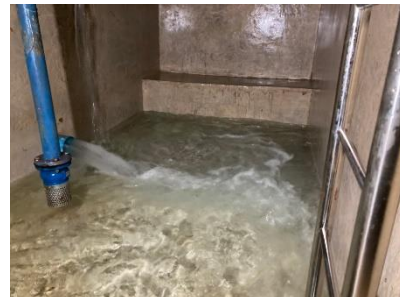
ภาพที่ 2-17 (ต่อ) การตรวจสอบและทำความสะอาดถังเก็บน้ำใต้ดิน
