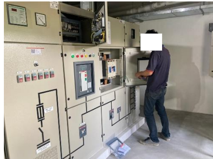
ภาพที่ 2-45 การตรวจสอบสายไฟหลักและอุปกรณ์ไฟฟ้า
