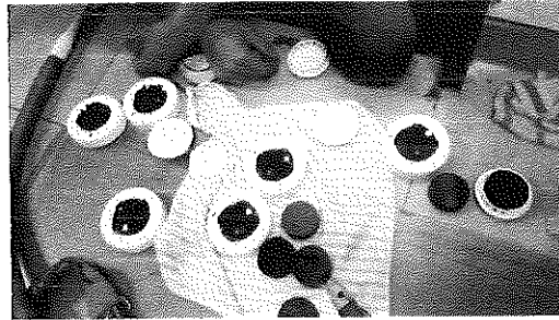
ทำการถอด SMOKE DETECTOR ZONE ทางเดินมาทำความสะอาดชั้น 15
