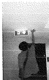
ทำการถอด SMOKE DETECTOR ZONE ทางเดินมาทำความสะอาดชั้น 19
