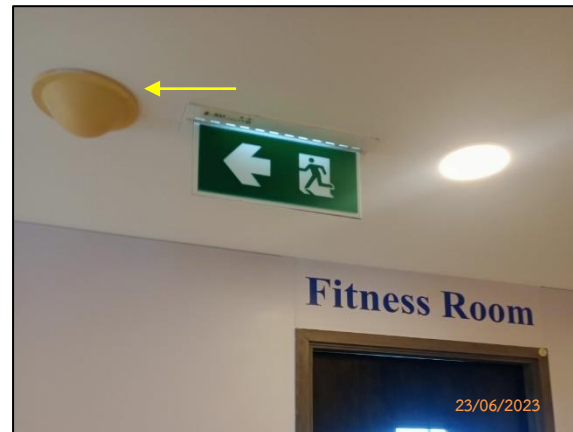
อุปกรณ์ตรวจจับควันและหัวกระจายน้ำดับเพลิง
