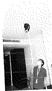
ทำการ TES SMOKE DETECTOR บริเวณห้อง 1011
