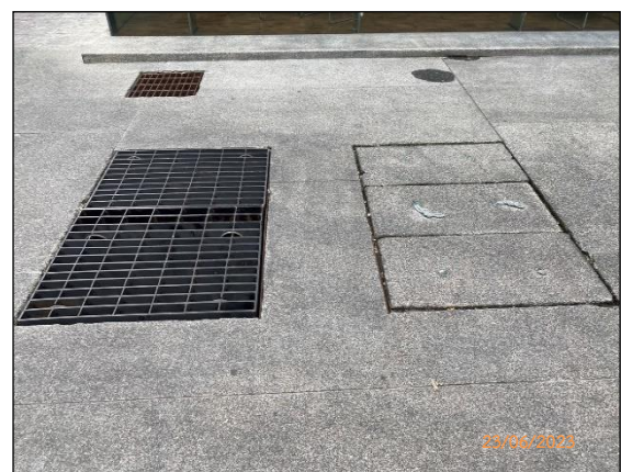
ภาพที่ 2.2-7 ตะแกรงดักเศษขยะที่บ่อพักน้ำสุดท้าย
