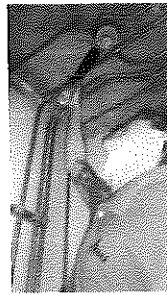
ทำการ TES SMOKE DETECTOR บริเวณห้องไฟฟ้าชั้น 10
