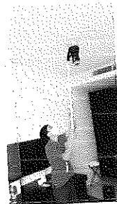
ทำการ TES SMOKE DETECTOR บริเวณห้อง 1412
