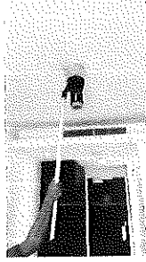
ทำการ TES SMOKE DETECTOR บริเวณห้อง 802
