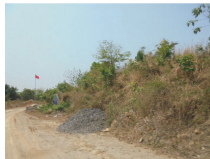
รูปที่ 2-6: แนวคันทำนบดินและการปลูกพืชคลุมดิน
