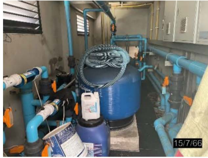
ภาพที่ 2-25 ระบบกรองน้ำของสระว่ายน้ำ ภาพที่ 2-26 การดูแลทำความสะอาด ล้างตะไคร่
