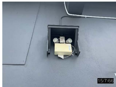
ภาพที่ 2-45 ระบบไฟฟ้า Emergency Light
