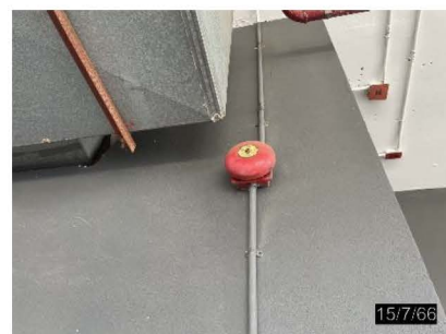
ภาพที่ 2-65 กริ่งสัญญาณเตือนภัย
