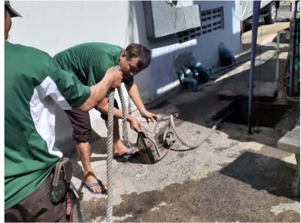
ภาพที่ 2-16 เจ้าหน้าที่ดูแล บำรุงรักษาระบบระบายน้ำให้มีสภาพดีไม่อุดตัน
