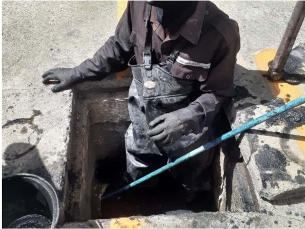
ภาพที่ 2-16 เจ้าหน้าที่ดูแล บำรุงรักษาระบบระบายน้ำให้มีสภาพดีไม่อุดตัน
