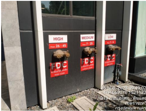
รูปที่ 34 หักรับน้ำดับเพลิง
