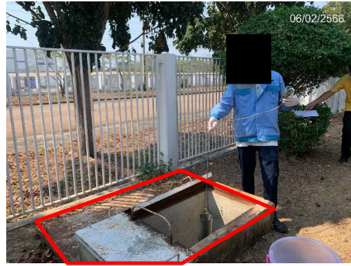
ภาพที่ 2.2-5 ป่อตรวจสอบลักษณะน้ำเสียก่อนระบายน้ำเสียเข้าสู่ระบบบำบัดน้ำเสียส่วนกลาง
