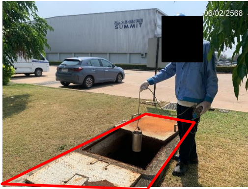
ภาพที่ 2.2-5 ป่อตรวจสอบลักษณะน้ำเสียก่อนระบายน้ำเสียเข้าสู่ระบบบำบัดน้ำเสียส่วนกลาง
