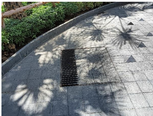
รูปที่ 3-62 ตะแกรงครอบท่อระบายน้ำทิ้ง (ภายนอกอาคาร)
