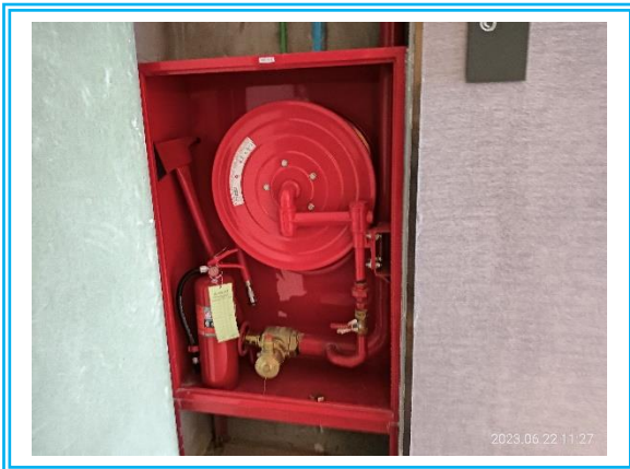
รูปที่ 3-46 ตู้เก็บสายฉีดน้ำดับเพลิง (Fire Hose Cabinet)
