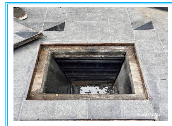
รูปที่ 3-20 ตะแกรงดักมูลฝอยก่อนระบายน้ำออกจาก โครงการ
