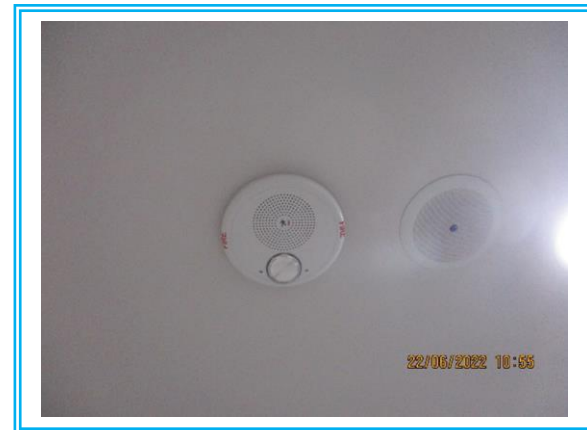
รูปที่ 3-38 เครื่องตรวจจับควัน (Smoke Detector)
