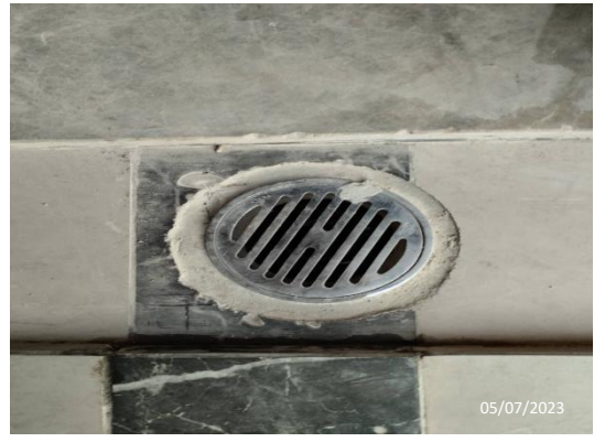
รูปที่ 3-61 ตะแกรงครอบท่อระบายน้ำทิ้ง (ภายในอาคาร)
