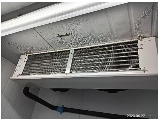
รูปที่ 3-26 ระบบปรับอากาศภายในห้องขยะเปียก (เพื่อป้องกันการเน่าเสีย)
