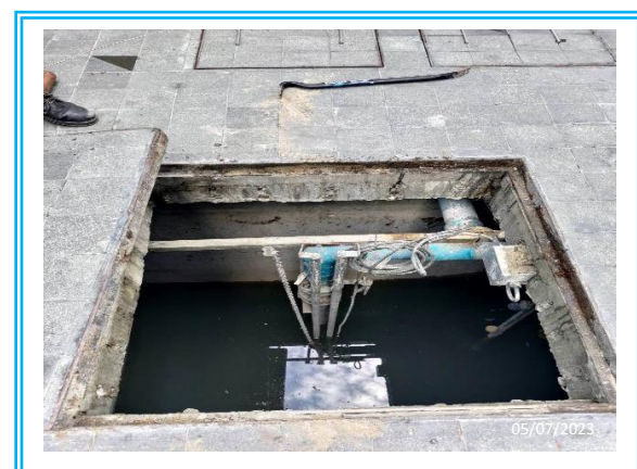
รูปที่ 3-18 ระบบระบายน้ำฝนถูกรวบรวมเข้าสู่ บ่อหนองน้ำ
