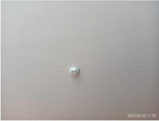
รูปที่ 3-39 เครื่องตรวจจับความร้อน (Heat Detector)
