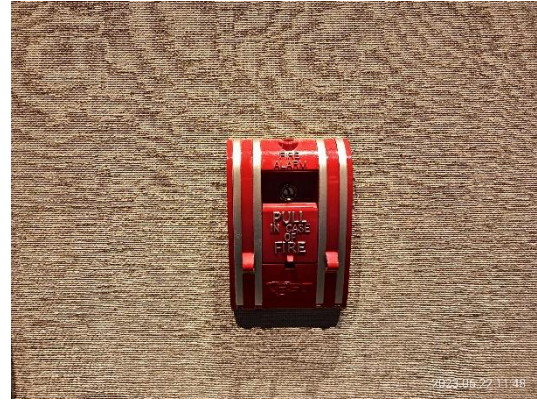
รูปที่ 3-40 ปุ่มกดแจ้งสัญญาณอัคคีภัย (Fire Alarm Manual Station)
