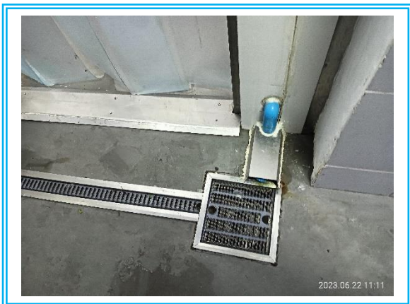
รูปที่ 3-22 ระบบระบายน้ำภายในห้องพัสดุโดยรวม
