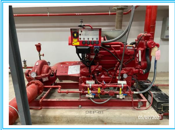
รูปที่ 3-44 เครื่องสูบน้ำดับเพลิง (Fire Pump)
