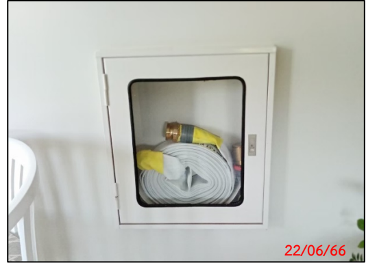
รูปที่ 2.2-8 สายส่งน้ำดับเพลิงภายในโครงการ
