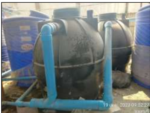
ภาพที่ 23 ถังบำบัดน้ำเสียสำเร็จรูป
