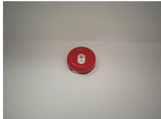
ภาพที่ 14 สัญญาณเสียงเตือนเหตุฉุกเฉิน
