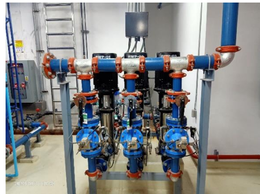
เครื่องสูบน้ำ Reuse
