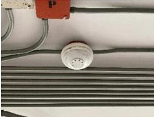
เครื่องตรวจจับความร้อน (Heat Detector; H)
