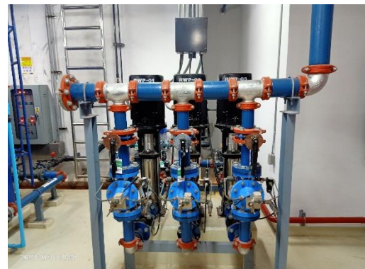
เครื่องสูบน้ำ Reuse
