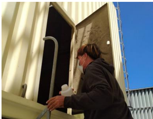
ภาพที่ 3.5.4-1 ตำแหน่งและวิธีการเก็บตัวอย่างน้ำจากหอผึ่งเย็น
