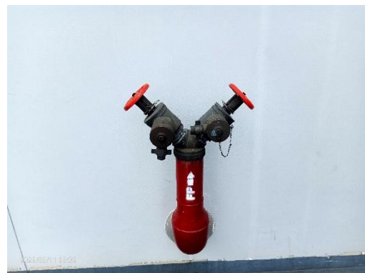
หัวฉีดน้ำหล่ออาคาร (Roof Manifold)
