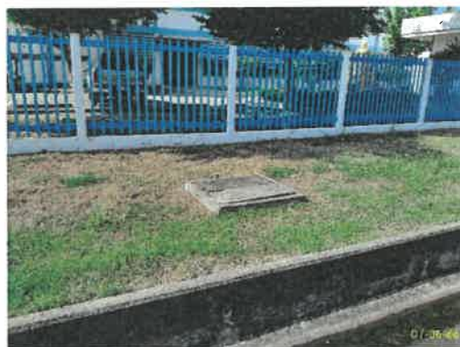
ภาพที่ 2.2-3 บ่อรับน้ำเสียของโรงงาน
