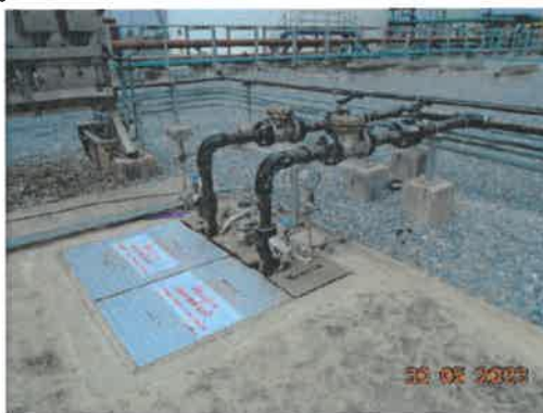
ภาพที่ 2.2-10 บ่อตรวจสอบคุณภาพน้ำทิ้ง พร้อมวาล์ว ของโรงไฟฟ้า
