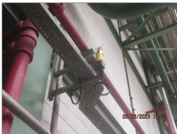
ภาพถ่ายที่ 2.2.2-52 ระบบสัญญาณเตือนแจ้งเหตุ ส่วนผลิต PC
