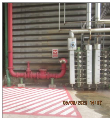
ภาพถ่ายที่ 2.2.2-48 ระบบป้องกันและระงับอัคคีภัยที่ติดตั้งภายในโรงงาน
