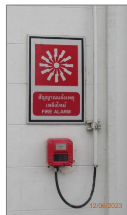
ภาพถ่ายที่ 2.2.2-59 ปุ่มแจ้งสัญญาณไฟไหม้ (Fire Alarm Button) ในส่วนผลิต CO
