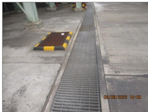
ภาพถ่ายที่ 2.2.2-15 รางระบายน้ำฝนภายในโครงการ ส่วนผลิต PC
