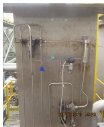
ภาพถ่ายที่ 2.2.2-13 อุปกรณ์ตรวจวัดอัตโนมัติ TOC-Online
