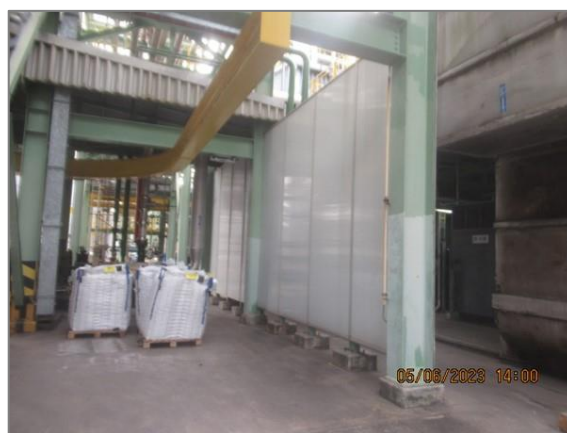
ภาพถ่ายที่ 2.2.2-28 บริเวณที่มีการติดตั้งอุปกรณ์ เพื่อลดความดังเสียงและป้องกันเสียง
