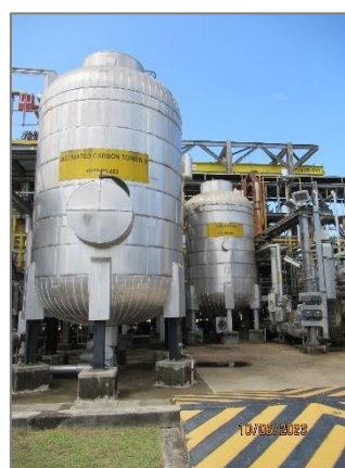
ภาพถ่ายที่ 2.2.2-9 หอถ่านกัมมันต์สำหรับดูดซับซัลเฟอร์
