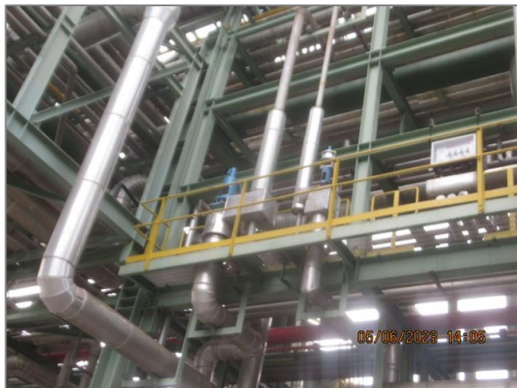
ภาพถ่ายที่ 2.2.2-43 ติดตั้งระบบ Safety Valves และฉนวนหุ้มท่อส่งไอน้ำในพื้นที่โครงการ
