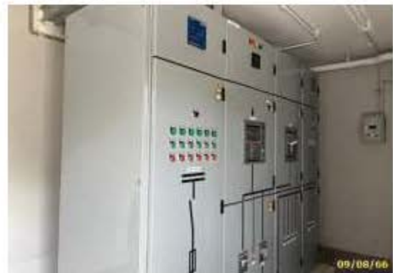
หม้อแปลงไฟฟ้า ขนาด 800 KVA พร้อมตู้ควบคุมไฟฟ้าอาคาร D
