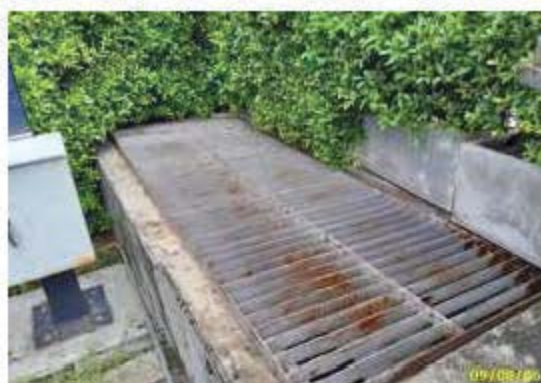
บ่อพักน้ำสุดท้าย พร้อมตะแกรงดักขยะก่อนระบายออกนอกโครงการ
