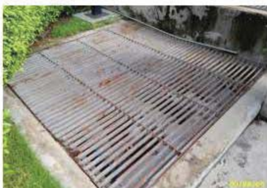
บ่อพักน้ำสุดท้าย พร้อมตะแกรงดักขยะก่อนระบายออกนอกโครงการ
