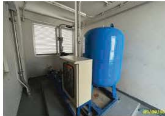
ถังเก็บน้ำชั้นดาดฟ้า และเครื่องปั้มน้ำ อาคาร E
