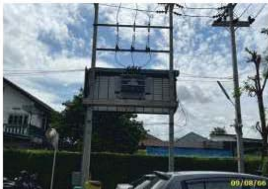
หม้อแปลงไฟฟ้า ขนาด 800 KVA พร้อมตู้ควบคุมไฟฟ้าอาคาร D
