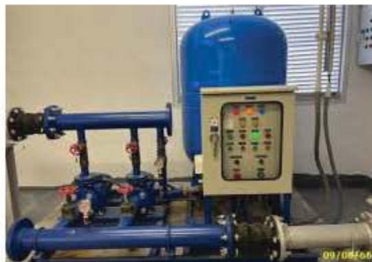
ถังเก็บน้ำชั้นดาดฟ้า และเครื่องปั้มน้ำ อาคาร A
