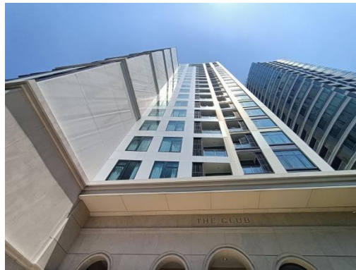
รูปที่ 2-23 รวากันตกความสูง 1.1 เมตร บริเวณระเบียงสำหรับแต่ละห้องพัก
