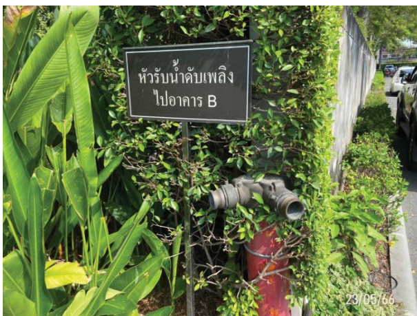
ห้รับน้ำดับเพลิง (Fire Department Connection)
