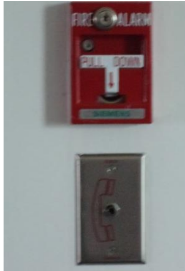
: ภาพแสดง : เครื่องแจ้งเหตุโดยใช้มือดึง (Fire Alarm Manual Station)
