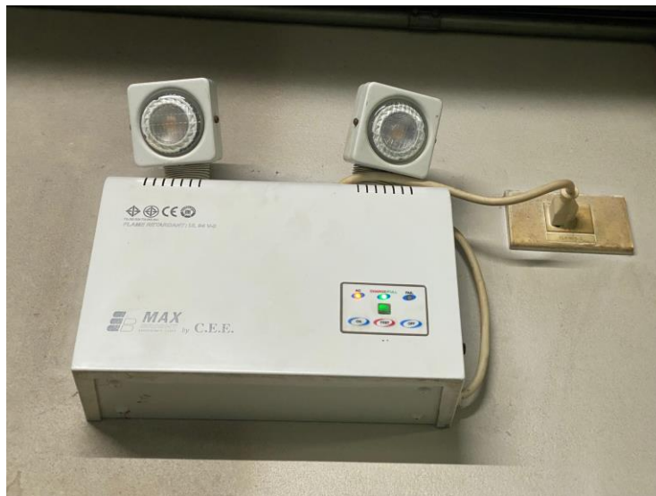
ภาพแสดง : เครื่องส่องสว่างฉุกเฉิน (Emergency Light)
