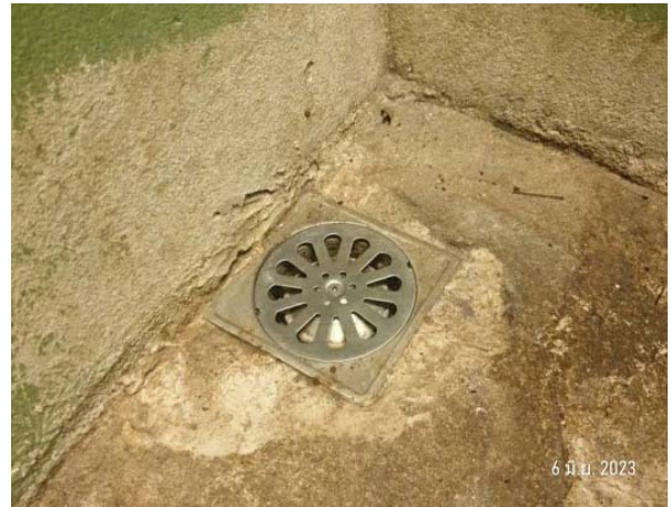
รูปที่ 2-23 ท่อรวบรวมน้ำจากห้องพักขยะมูลฝอย
