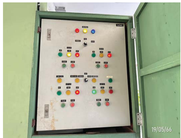
รูปที่ 2-13 ตู้ควบคุมระบบบำบัดน้ำเสีย
