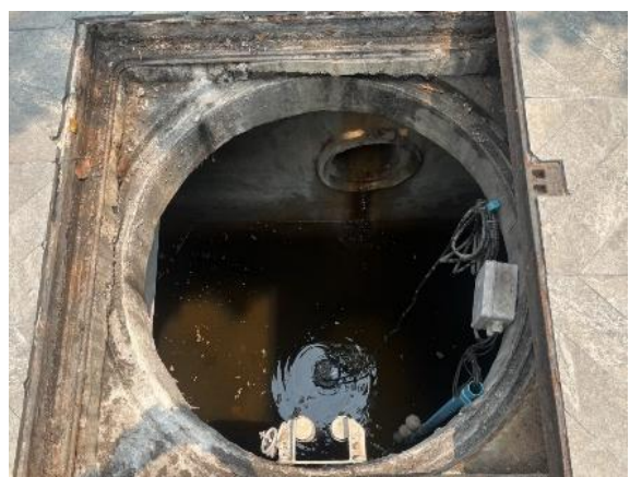
รูปที่ 2-43 จัดให้มีการตรวจสอบระดับน้ำในบ่อพัก และท่อ ระบายน้ำ
