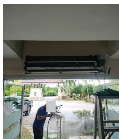
รูปที่ 2-5 การทำความสะอาดเครื่องปรับอากาศ
