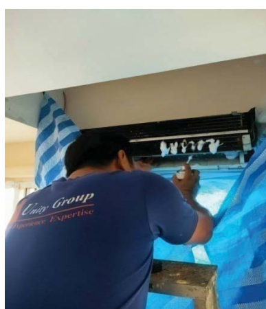
รูปที่ 2-5 การทำความสะอาดเครื่องปรับอากาศ
