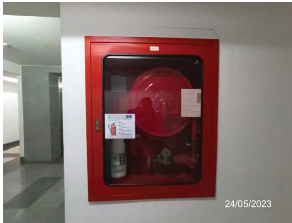
ตู้เก็บสายฉีดน้ำดับเพลิงอุปกรณ์ (FHC)
