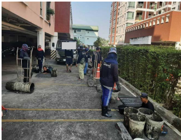
รูปที่ 2-10 การทำความสะอาดระบบระบายน้ำใต้ดิน
