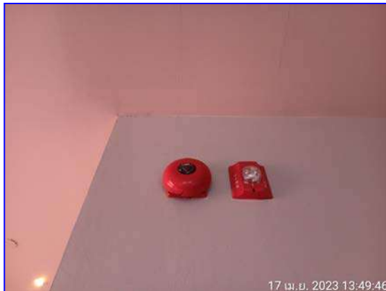
รูปที่ 2.25 สัญญาณแจ้งเตือนเหตุเพลิงไหม้
