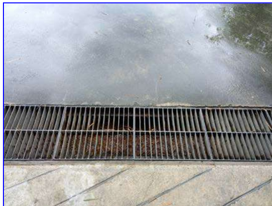
รูปที่ 2.46 รางระบายน้ำมีตะแกรงดักขยะ
