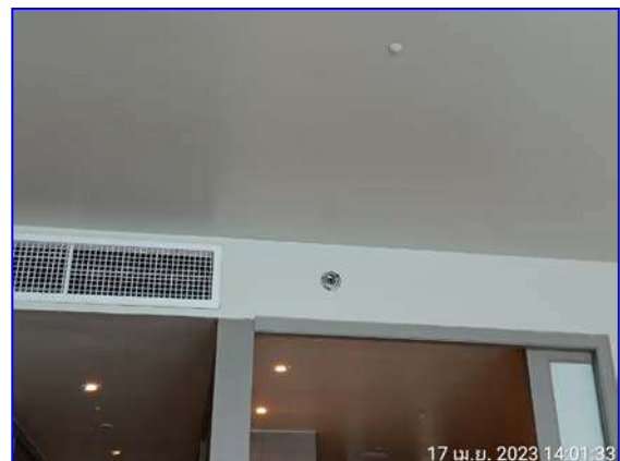
รูปที่ 2.26 อุปกรณ์ตรวจจับควัน และสปริงเกอร์ดับเพลิง
