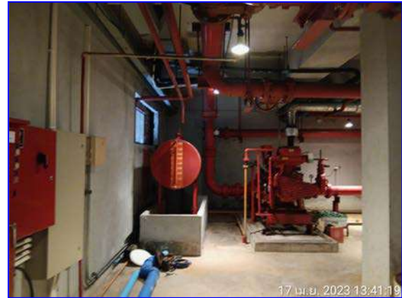
รูปที่ 2.31 ระบบ fire pump
