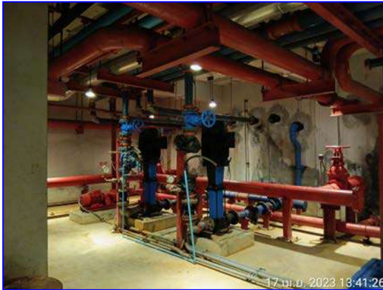
รูปที่ 2.31 ระบบ fire pump
