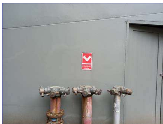
รูปที่ 2.29 หัวรับน้ำดับเพลิง และหัวจ่ายน้ำดับเพลิง
