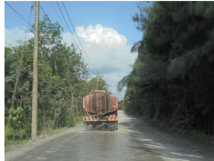
รูปที่ 2-12: การฉีดพรมน้ำบนเส้นทางขนส่งแร่
