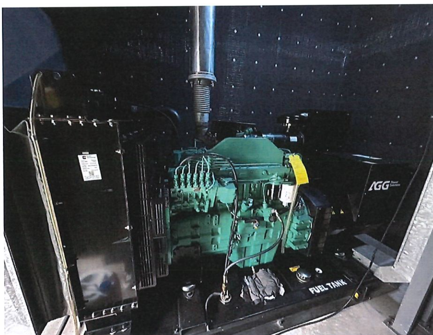
ภาพที่ 1.54 ภาพระบบสำรองไฟฟ้า
