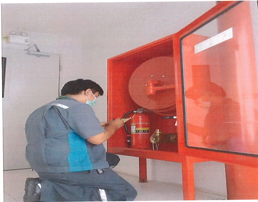
ภาพที่ 1.42 ภาพผู้ทำการตรวจเช็คอุปกรณ์ป้องกันอัคคีภัย
