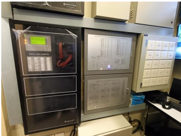
แผงควบคุม Fire Alarm ของอาคารชุดพักอาศัย
