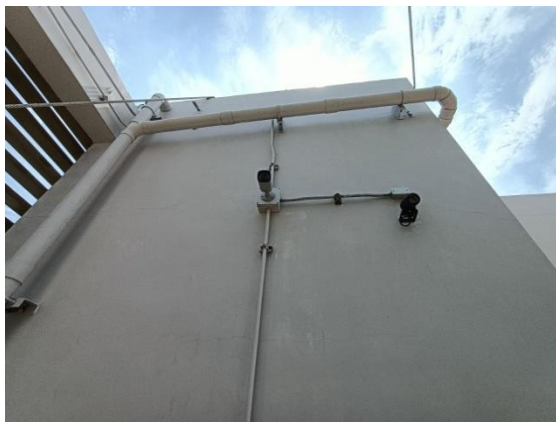
รูปที่ 2-26 กล้องวงจรปิด และจุดควบคุมระบบกล้องวงจรปิดของโครงการ
