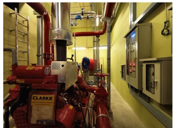
รูปที่ 2-46 ปั๊มน้ำใช้และปั๊มน้ำดับเพลิง
