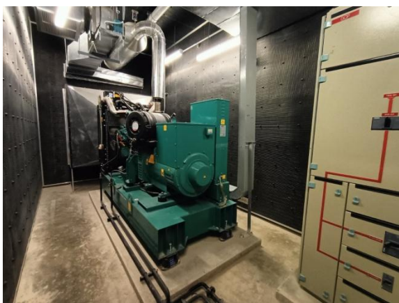
รูปที่ 2-29 จัดให้มีเครื่องกำเนิดไฟฟ้าสำรอง
