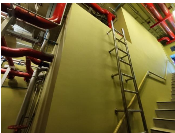
รูปที่ 2-45 ถังเก็บน้ำดับเพลิง
