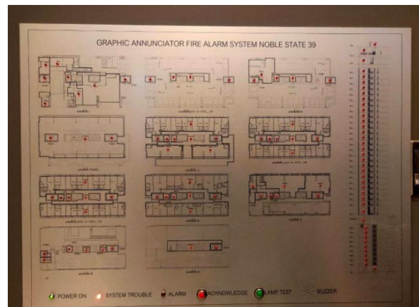
แผงควบคุม Fire Alarm ของอาคารชุดพาณิชย์
