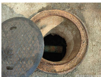
บ่อบำบัดน้ำเสียสำเร็จรูปของอาคารทำการดับเพลิงและหน่วยกู้ภัยทางด้านซ้ายมือ
