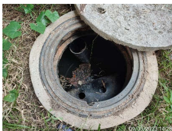
บ่อบำบัดน้ำหลังผ่านระบบบำบัดน้ำเสียสำเร็จรูปของอาคารผู้โดยสารขาเข้า
