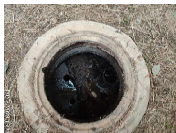
บ่อบำบัดน้ำก่อนเข้าระบบบำบัดน้ำเสียสำเร็จรูปของอาคารผู้โดยสารขาออก
