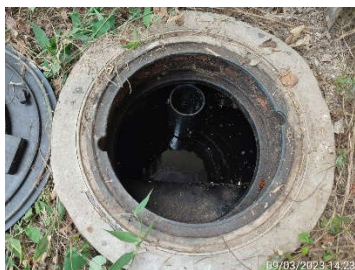
บ่อบำบัดน้ำก่อนเข้าระบบบำบัดน้ำเสียสำเร็จรูปของอาคารผู้โดยสารขาเข้า
