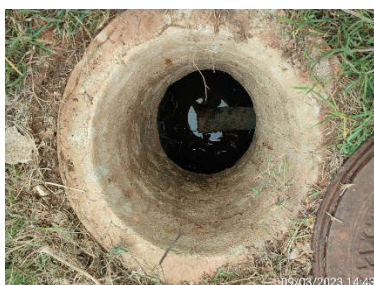
บ่อบำบัดน้ำเสียสำเร็จรูปของอาคารทำการดับเพลิงและหน่วยกู้ภัยทางด้านขวามือ
