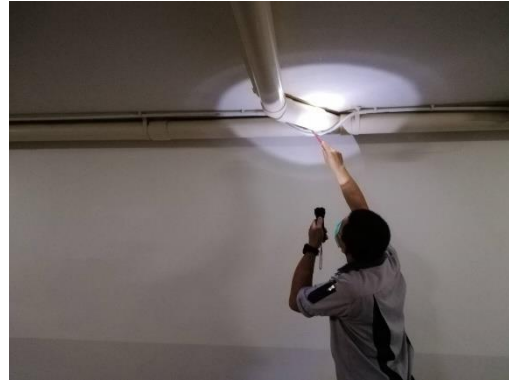
รูปที่ 15 ตรวจสอบรอยรั่วของท่อจ่ายน้ำ
