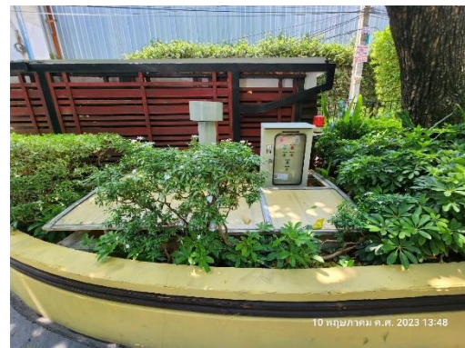
รูปที่ 37 ตัวควบคุมระบบบำบัดน้ำเสีย
