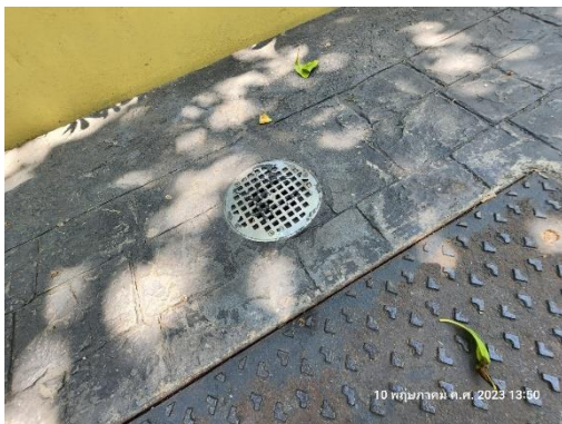
รูปที่ 4 ตะแกรงดักขยะที่บ่อพักน้ำสุดท้าย
