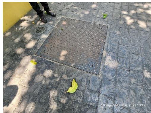
รูปที่ 4 ตะแกรงดักขยะที่บ่อพักน้ำสุดท้าย
