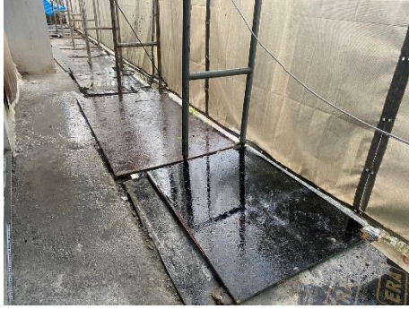
ภาพที่ 2.2-37 การป้องกันวัสดุตกหล่นจากอาคาร
