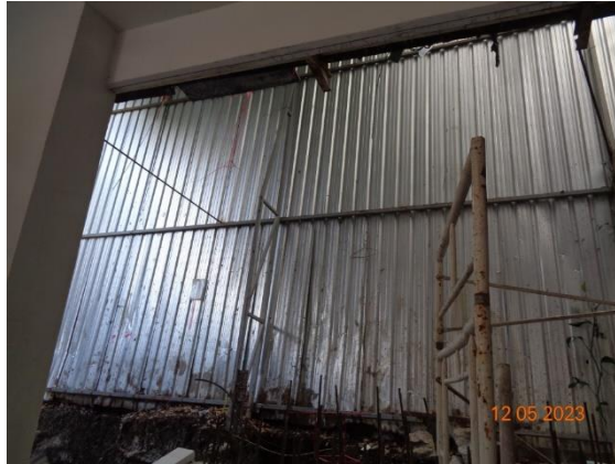
ภาพที่ 3.2.2-2 รื้อ Metal Sheet ตามแนวเขตพื้นที่ก่อสร้างโครงการ
