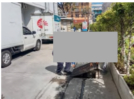
ภาพที่ 2.2-21 การขุดลอกท่อระบายน้ำ
