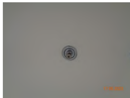
ภาพที่ 2.2-33 ระบบหัวกระจายน้ำดับเพลิง (Sprinkler System)
