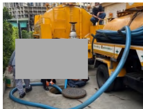
ภาพที่ 2.2-14 การสูบน้ำจากตะกอน จากระบบบำบัดน้ำเสีย
