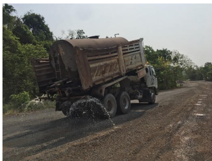
รูปที่ 2-9: การฉีดพรมน้ำบนเส้นทางขนส่งแร่
