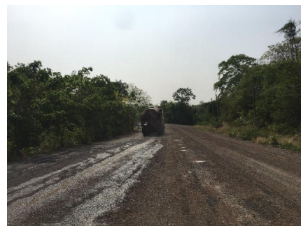
รูปที่ 2-9: การฉีดพรมน้ำบนเส้นทางขนส่งแร่
