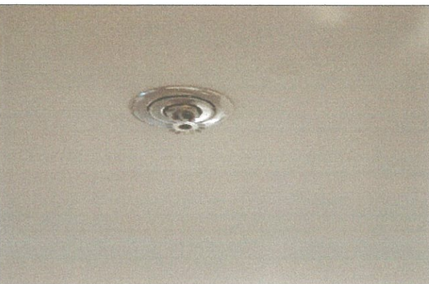
รูปที่ 3-45 ระบบหัวกระจายน้ำดับเพลิง
