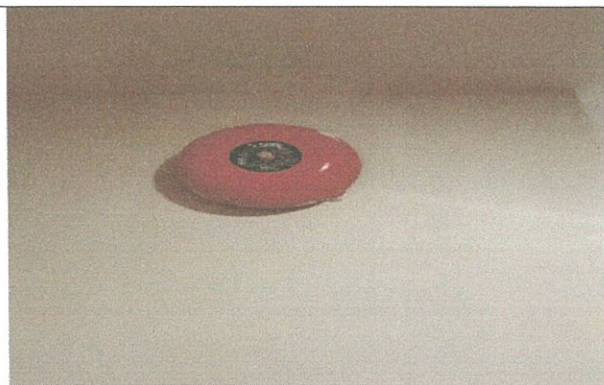
รูปที่ 3-43 กริ่งสัญญาณแจ้งเหตุ (Fire Alarm Bell)
