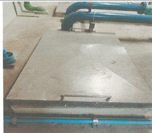
รูปที่ 3-15 ถังสำรองน้ำใต้ดิน
