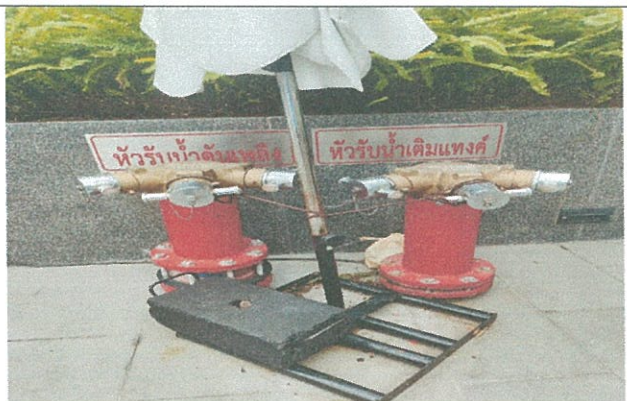
รูปที่ 3-50 หัวรับน้ำดับเพลิง (Fire Hydrant)
