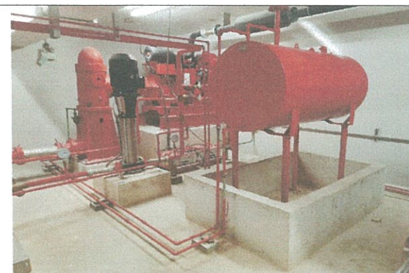
รูปที่ 3-40 เครื่องสูบน้ำดับเพลิง
