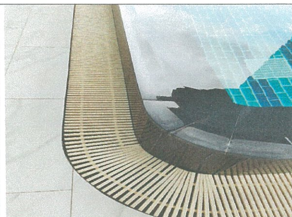
รูปที่ 3-32 รางระบายน้ำล้นมีฝาปิดรอบสระว่ายน้ำ
