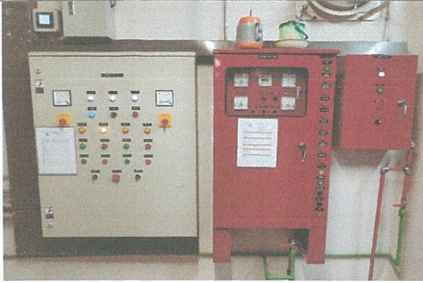
รูปที่ 3-41 ระบบมิเตอร์ไฟฟ้าสำหรับห้องเครื่องสูบน้ำ ดับเพลิง
