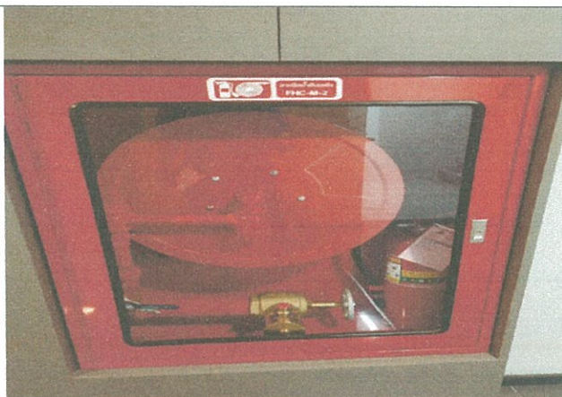
รูปที่ 3-51 ตู้เก็บสายดับเพลิง (Fire Hose Cabinet)
