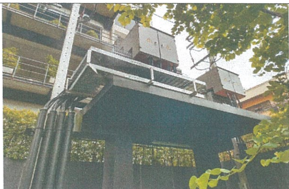
รูปที่ 3-39 หม้อแปลงไฟฟ้ามีการติดป้ายอันตราย ไฟฟ้าแรงสูง
