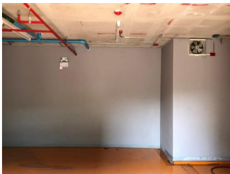
ภาพที่ 2-35 พัดลมดูดอากาศภายในห้องพักมูลฝอย
