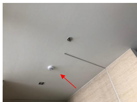
ภาพที่ 2-56 ตรวจจับควัน (Smoke Detector)
