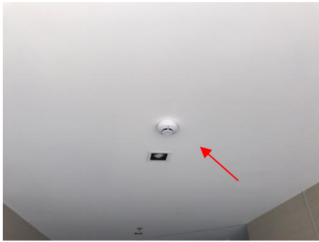
ภาพที่ 2-57 เครื่องตรวจจับความร้อน (Heat Detector)
