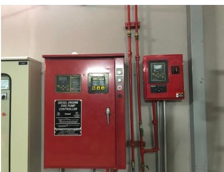
ภาพที่ 2-55 แผงควบคุม (FCP)
