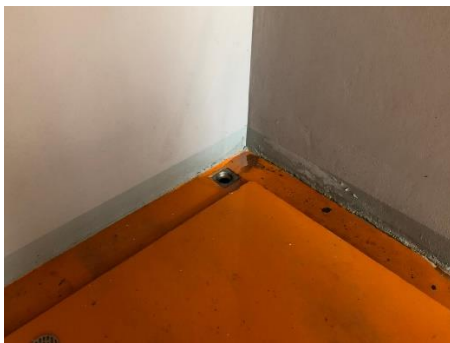
ภาพที่ 2-33 ท่อรวมน้ำจากห้องพักมูลฝอยรวม
