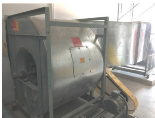
ภาพที่ 1-9 (ค) ระบบระบายอากาศโดยวิธีกล
