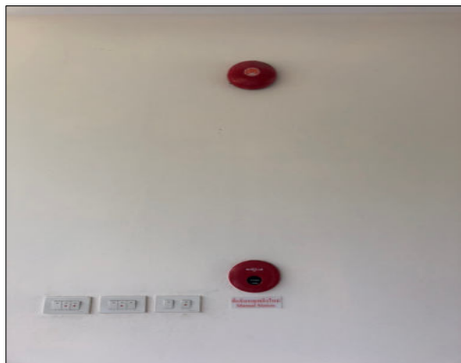
ภาพที่ 1-11 อุปกรณ์แจ้งเหตุเพลิงไหม้
