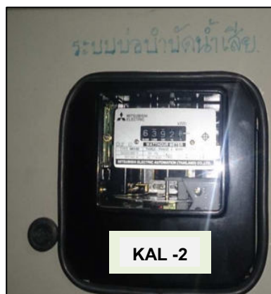
ภาพที่ 2-9 อุปกรณ์ประหยัดพลังงานและการติดตั้งเครื่องวัดปริมาณการใช้ไฟฟ้าแยกเฉพาะระบบบำบัด
