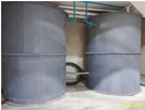
ภาพที่ 2.2-22 ระบบกำจัด Aerosol และก๊าซมีเทน
