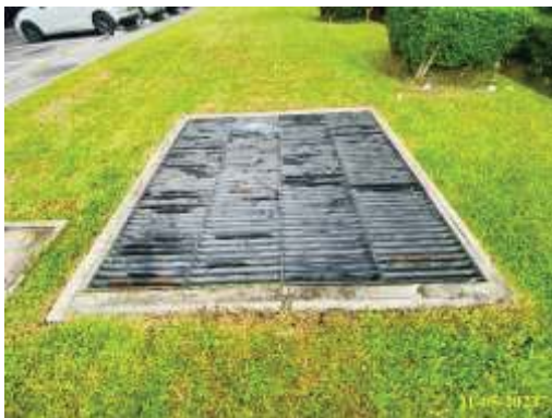
ภาพที่ 2.2-25 ตะแกรงดักขยะ
