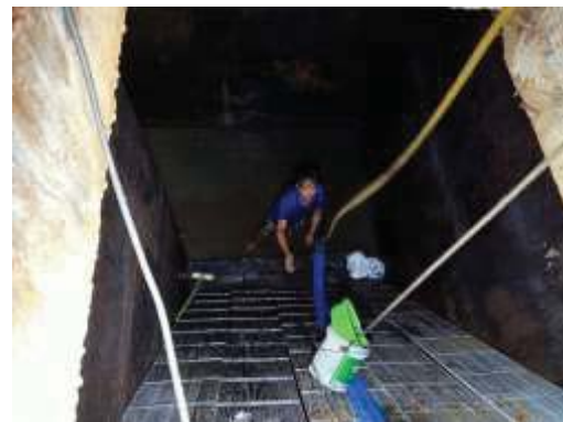
ภาพที่ 2.2-25 ตะแกรงดักขยะ
