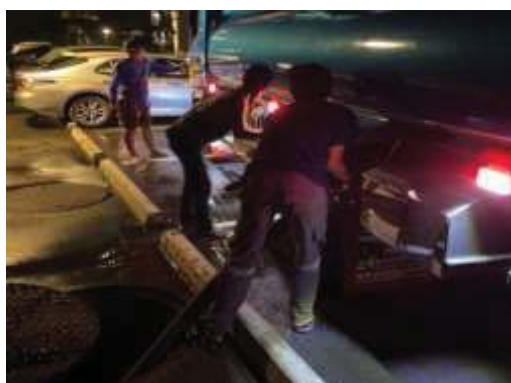
ภาพที่ 2.2-75 สุกตะกอนระบบบำบัดน้ำเสีย
