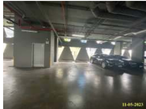
ภาพที่ 2.2-9 ช่องเปิดระบายอากาศลานจอดรถ
