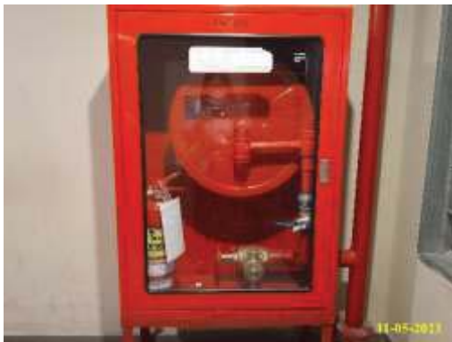
ตู้เก็บสารชนิดน้ำดับเพลิงและอุปกรณ์
