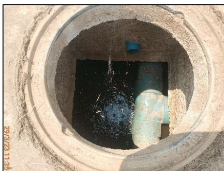
บ่อกักน้ำหลังผ่านระบบบำบัดน้ำเสียอาคารที่พักผู้โดยสาร ชุดที่ 3
